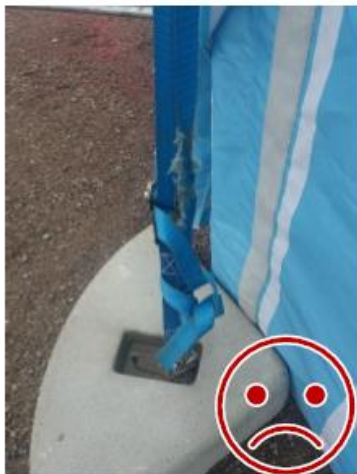
Kuormaliina on kulunut.
