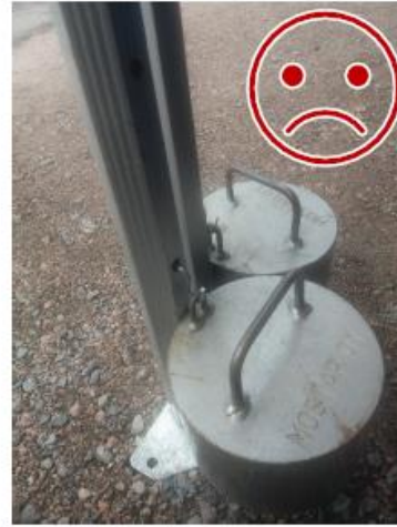
Painojen teräskoukku ei ole lukittu. Teräs leikkaa alumiinia, jolloin kiinnitys ei ole toimiva.
